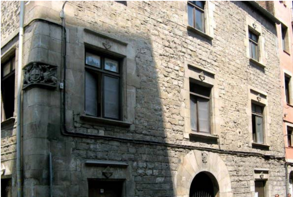
Vista de la façana principal de la Casa de la Generalitat
